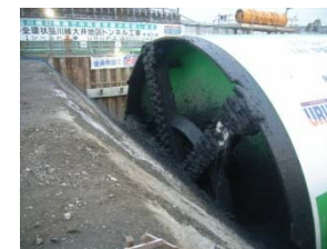
発進状況(高速道路工事)
