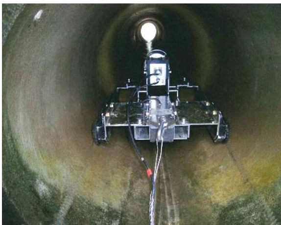
ロボットカメラによるコンクリート劣化状況調査
