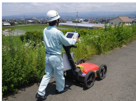
管理用道路下の空洞化調査
