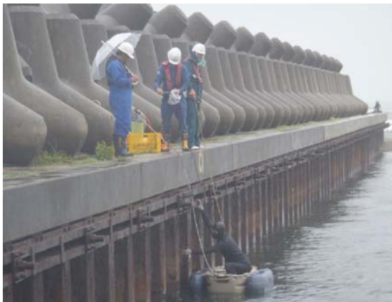
潜水夫による水中部劣化調査
