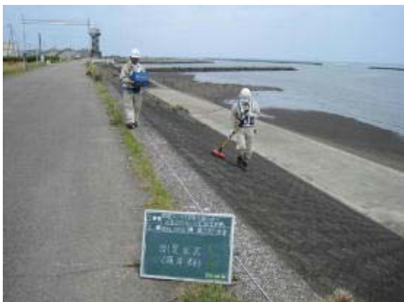
護岸の背面空洞化調査
