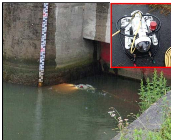
水中カメラによる水中部劣化調査
