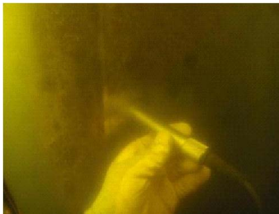
水中部ゲート戸当たり板厚調査
