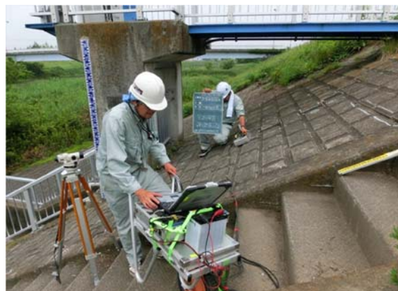
護岸の背面空洞化調査
