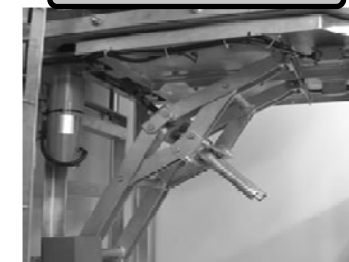
換気口浸水防止機
