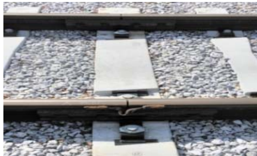
線路設備 （軌道改良（PCまくら木化））
