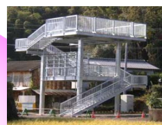
【津波避難タワー】
