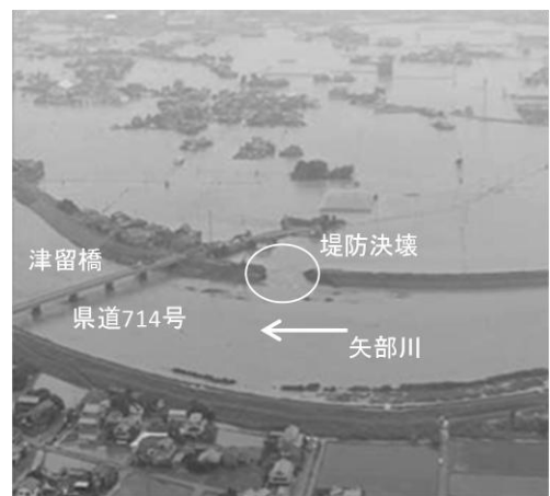
矢部川流域の被災状況（福岡県柳川市） やながわ
