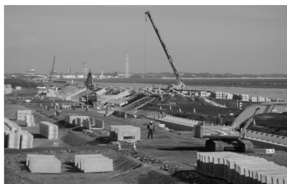
復旧工事実施状況
