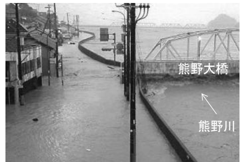
堤防越水による浸水状況（三重県紀宝町） きほうちょう
