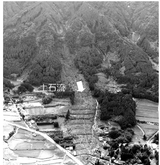
被災状況（熊本県阿蘇市一の宮町坂梨 あそ いちのみやまちさかなし ）
