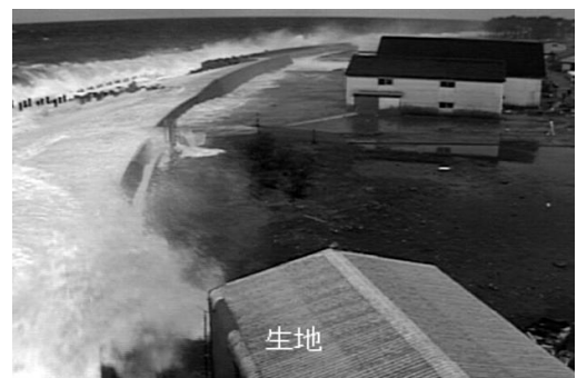
下新川海岸の被災状況（富山県黒部市 くろべ ）
