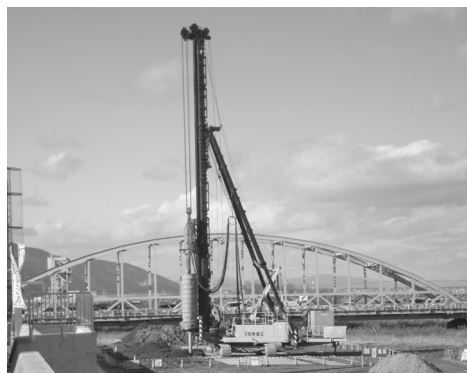
深層混合処理による液状化対策 いびくわな 揖斐川（三重県桑名市）
