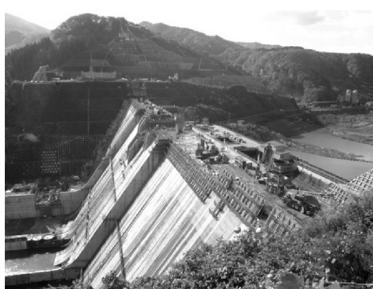
ダム本体の打設状況
