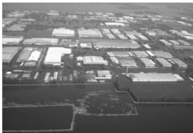
ロジャナ工業団地の浸水状況
