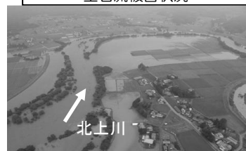
岩手県紫波町 北上川水系北上川 氾濫状況
