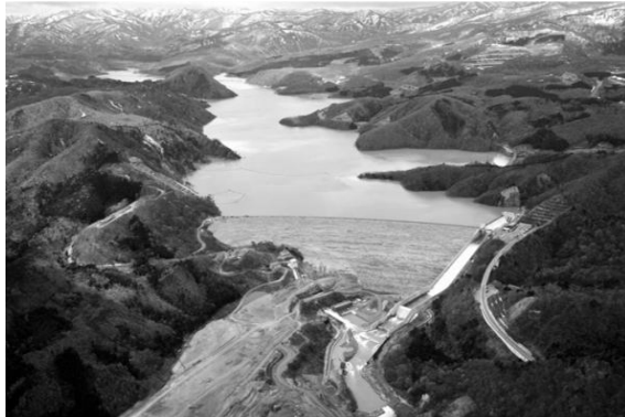
いさわ きたかみがわ 【胆沢ダム（北上川水系）】 事業主体：東北地方整備局 所在地：岩手県奥州市 完成年月：平成 26 年 3 月（予定）
