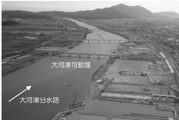
おおこうづかどうせき しなのがわ 【大河津可動堰（信濃川水系）】 事業主体：北陸地方整備局 所在地：新潟県長岡市、燕市 完成年月：平成 26 年 6 月（予定）
