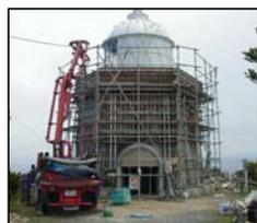
▲鉄筋コンクリート等を用い建物の耐震性能を確保する。
