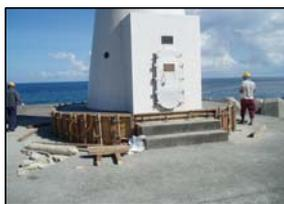
▲鉄筋コンクリートを用い建物の耐波浪強度の低下を予防する。
