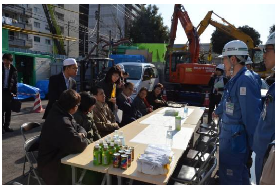
下水道推進工法工事現場の視察
