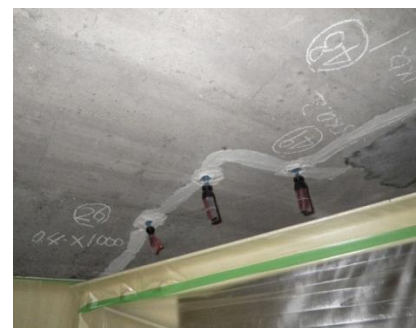
低圧注入器具による注入状況
