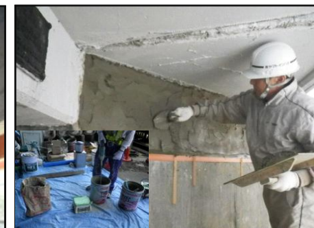
断面修復左官作業
