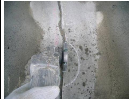
充てん工法のひび割れ部カット状況
