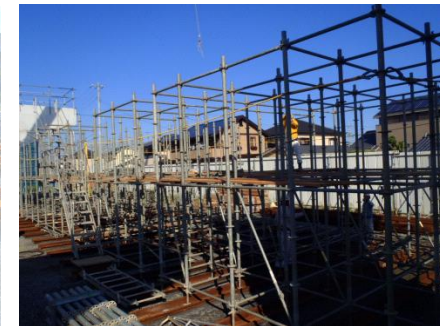
くさび結合支保設置
