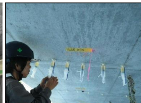
低圧注入器具による注入状況
