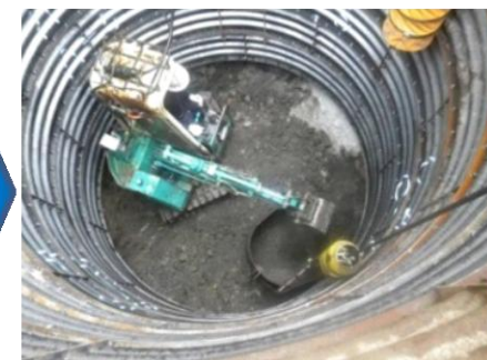
小型バックホウ(電動式 山積0.03m 3 )
