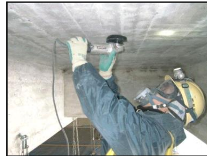
下地処理状況
