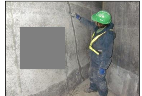
充てん材の充てん状況
