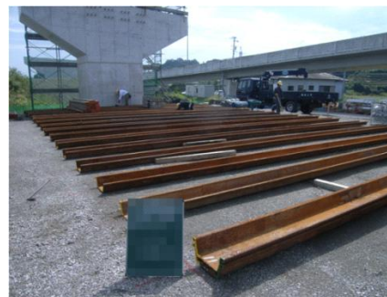
基礎用鋼材設置
