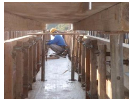
パイプサポート支保
