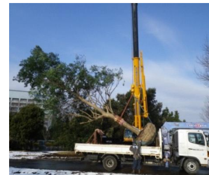
樹木積込み状況
