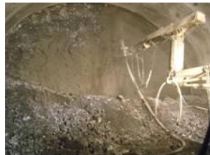
コンクリート吹付状況
