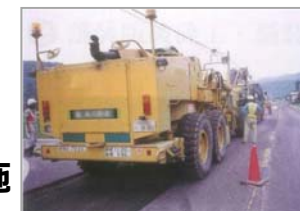
路面切削作業
