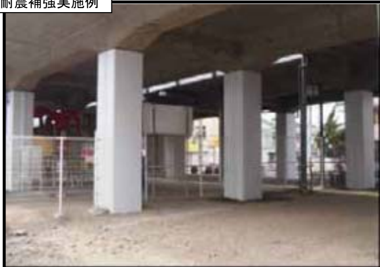
耐震補強実施例
