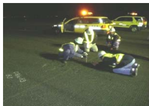
(基本施設点検実施状況)
