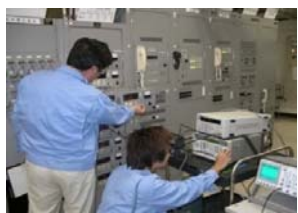
(航空保安施設点検実施状況)
