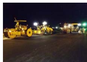
(老朽化した滑走路舗装の改良)
