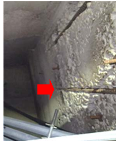
ジャンカ、鉄筋の露出
