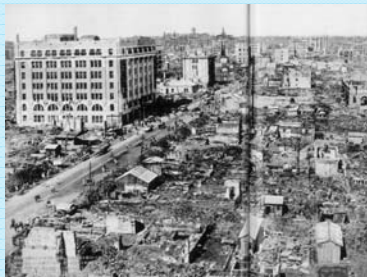
被災後の様子(東京都京橋)
