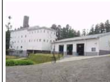
ゴミ処理施設の整備
