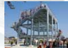
津波避難タワー
