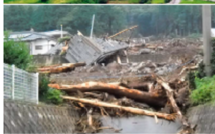
土石流に押しつぶされた家屋(熊本県南阿蘇村新所地区)
