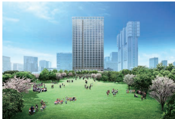
ヒートアイランド対策として、夏季の卓越風等を考慮し、臨海部から都心に向けて冷涼な空気を誘導できる風の道を確保する計画に基づき緑地を創出。四季を感じさせる植栽計画を施している（品川シーズンテラス）
