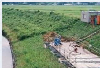
施工状況(陸上)
