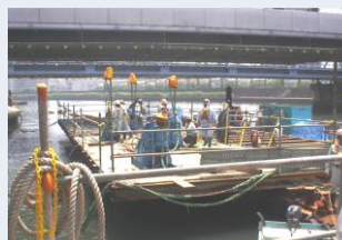
施工状況(水上)
