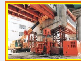
ハンドリング装置を使用した鋼管吊込み状況
