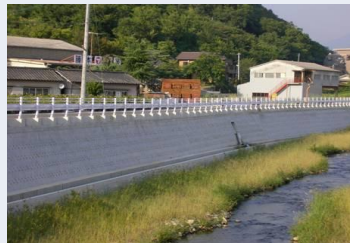
写真-2 ブロック積擁壁の上に設置状況
