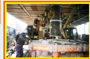
ハンドリング装置を使用した鋼管吊込み状況
