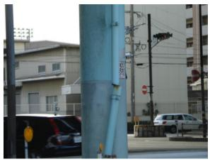
例:腐食により、明らかな断面欠損、貫通や破断がある場合
