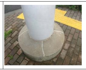
例:目視で視認できるひびわれがあり、放置すると雨水の内部への侵入などに より劣化が進展することが見込まれる場合
