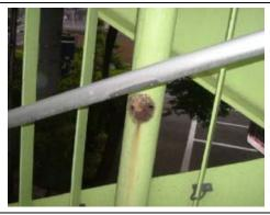
例:取付金具が脱落しており、利用者の安全性が損なわれている、また、脱落 に至る可能性がある場合
