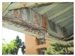
例:横断歩道橋全体の耐荷力への影響は少ないものの、局部で腐食が進行しつ つあり、放置すると影響の拡大が確実と見込まれる場合
