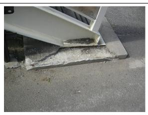
例:顕著なひびわれが発生しており、橋台の機能が低下している場合
