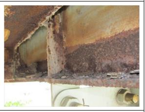
例: 広がりのある顕著な腐食が生じており、局部的に明らかな板厚減少が確認 でき、断面欠損に至ると構造安全性が損なわれる可能性がある場合
