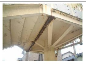
例:広がりのある顕著な腐食が生じており、局部的に明らかな板厚減少が確認 でき、断面欠損に至ると構造安全性が損なわれる可能性がある場合
