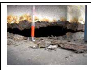
例:腐食により、構造安全性が損なわれる断面欠損、貫通や著しい板厚減少が ある場合
