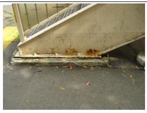
例:目視で視認できるひびわれがあり、放置すると雨水の内部への侵入などに より劣化が進展することが見込まれる場合
