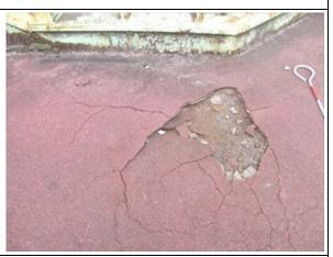
例:広がりのある顕著な舗装劣化が進行しており、利用者の安全性が損なわれている、また、雨水の内部への侵入などにより床版の劣化が進展することが見込まれる場合
