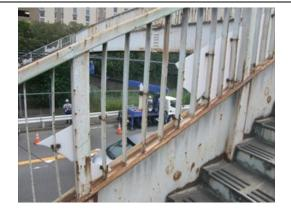
例:取付金具の破断により、目隠し板·裾隠し板の落下に至る可能性がある場合。あるいは、目隠し板・裾隠し板の機能が損なわれている場合。
