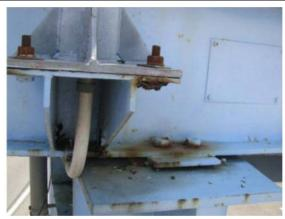
例:広がりのある顕著な腐食が生じており、局部的に明確な板厚減少が確認でき、断面欠損に至ると倒壊・落下する可能性がある場合
