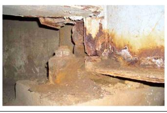
例:腐食により、構造安全性が損なわれる断面欠損、貫通、著しい板厚減少が ある場合
