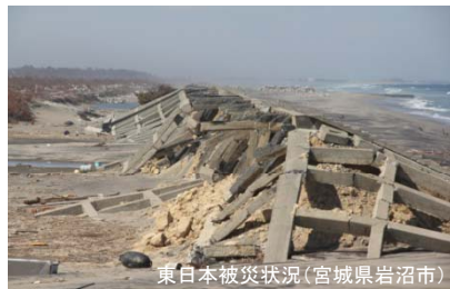
東日本被災状況(宮城県岩沼市)
