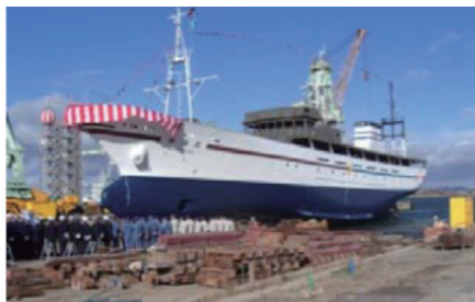
一部復旧した造船所での進水式（石巻地区）
