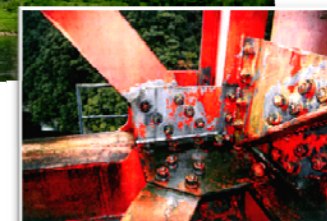
主桁の腐食
