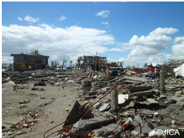
パロ～タクロバン空港にかけての被災状況
