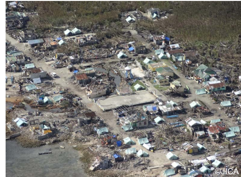
ギゴソ周辺の被害状況
