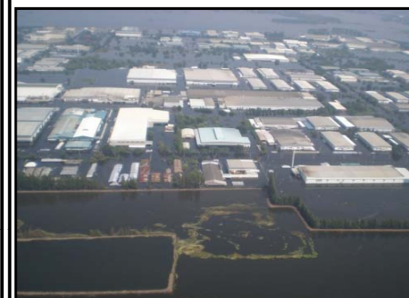
平成23年10月 タイ・チャオプラヤ川の氾濫によるロジャナ工業団地浸水状況
