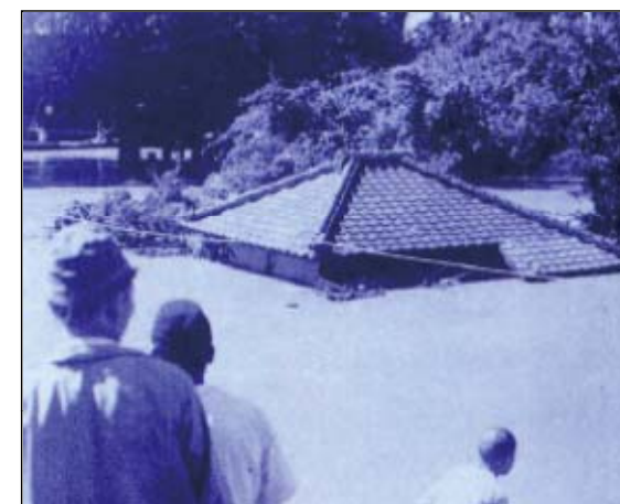
被災地域の状況(埼玉県川口市) 16
