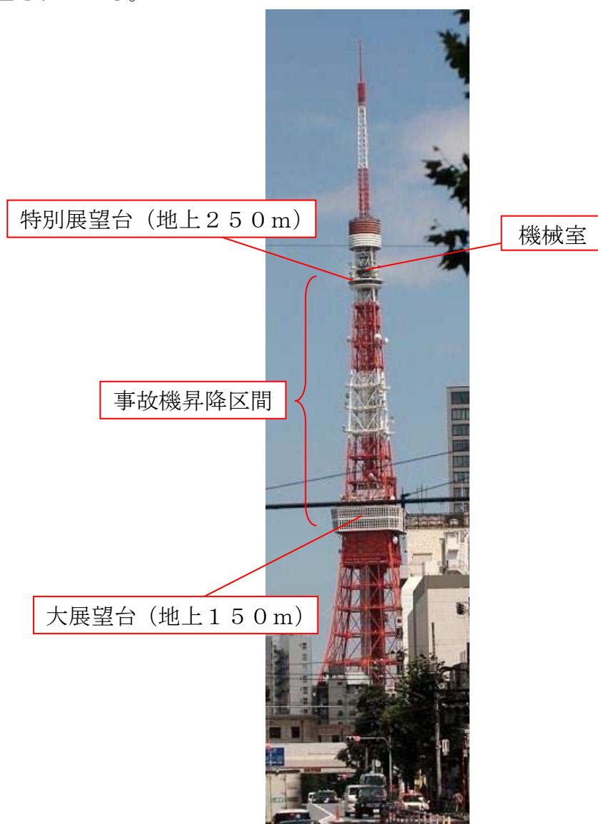
写真1. 事故機の昇降区間
