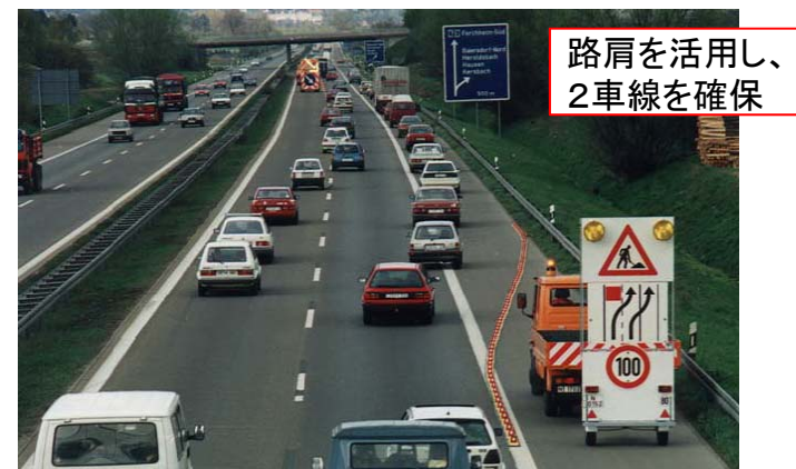
車線拡幅(アウトバーン8号線)
