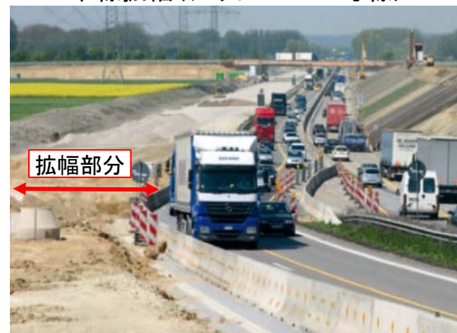
車線拡幅(アウトバーン8号線)
