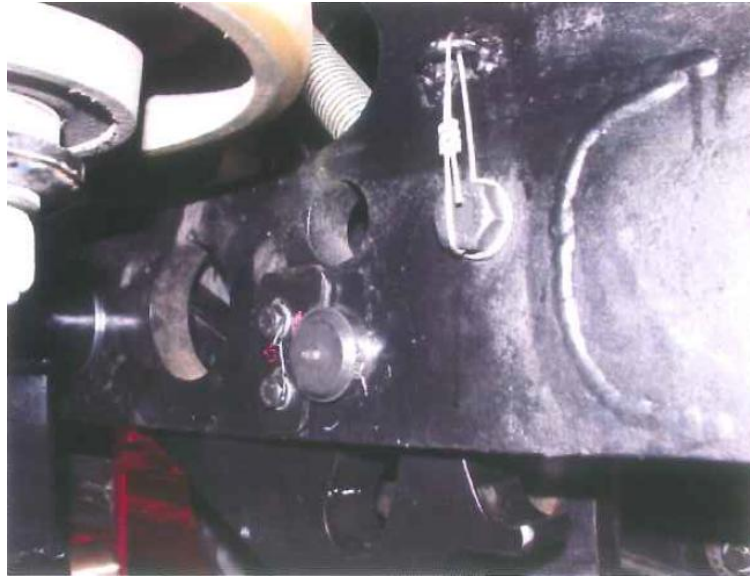
写真 17. 緩み止め兼落下防止ワイヤー施工例
