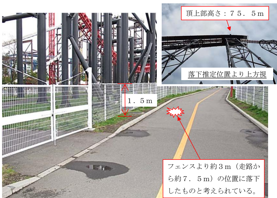
写真7. 貫通ボルト落下推定場所
