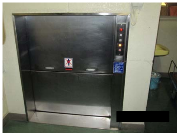
事故 I 事故機の出し入れ口
