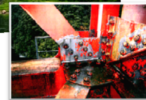
主桁の腐食
