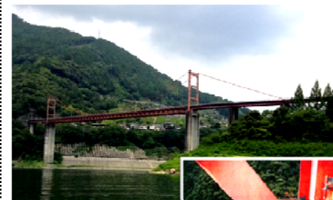
大渡ダム大橋
