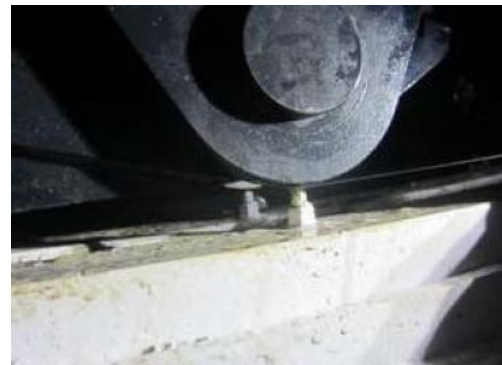
写真7. 車両とボルトの干渉
