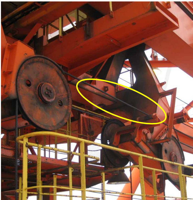
ワイヤロープの目視 (○印は摩耗し易い箇所)
