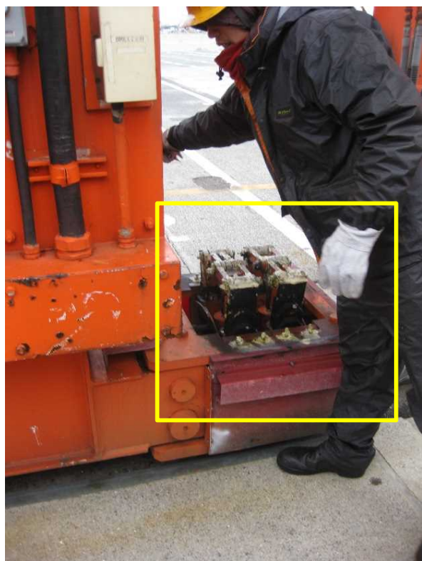
ボックスを開放した目視点検 (レールクランプ)
