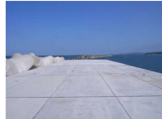
③上部工完成
