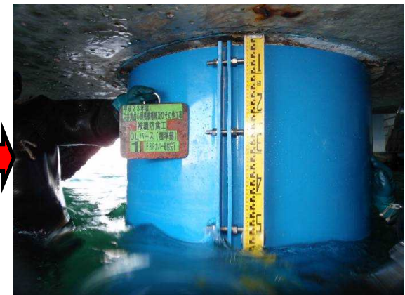
③ 棧橋脚部保護完成
