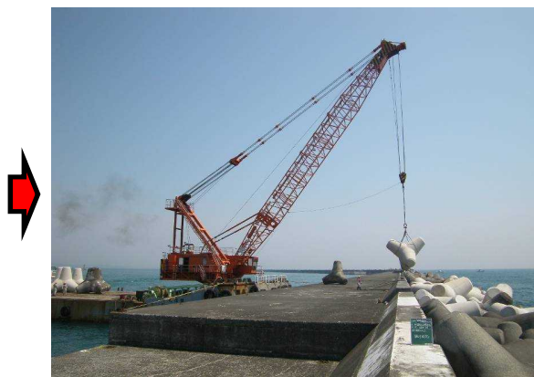
②工事(ブロック積増)
