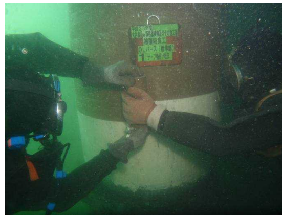
② 工事(被覆防食)
