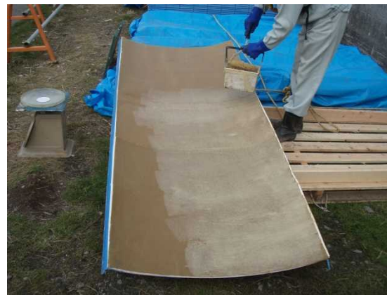
② 工事(被覆防食)
