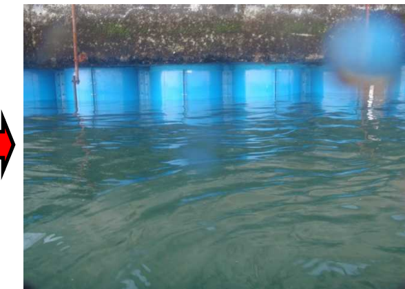
③ 矢板部保護完成
