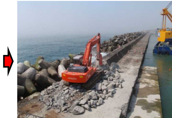
②工事(上部取壊し状況)
