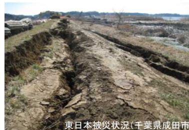
東日本被災状況(千葉県成田市)
