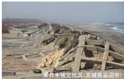
東日本被災状況(宮城県岩沼市)
