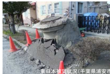
東日本被災状況(千葉県浦安市)
