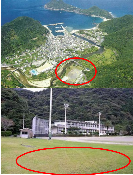
地中熱探熱管埋設エリア
