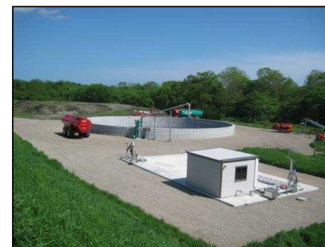
■取組事例(肥培かんがい施設の整備)
