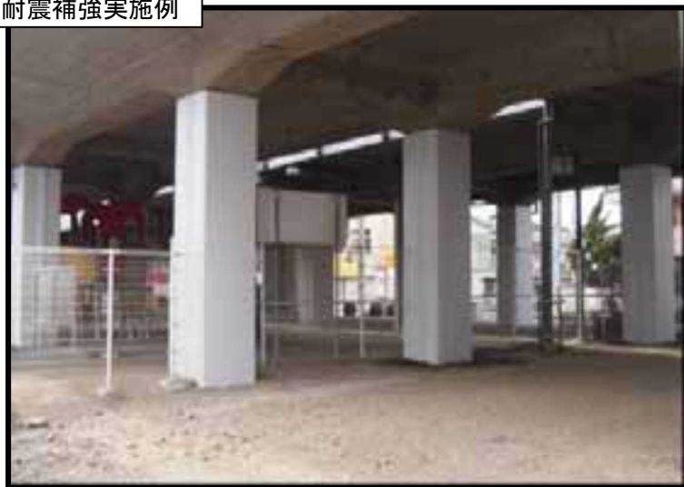
耐震補強実施例
