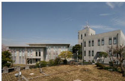
全体保存の例 (横浜地方気象台)
