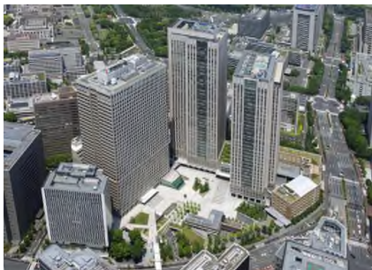
中央合同庁舎7号館 (Ⅰ類施設)
