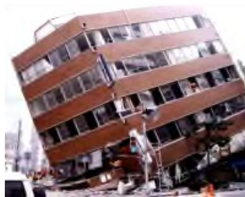
事務所ビル1、2階の崩壊
