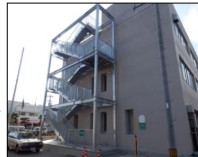
屋外避難階段の設置例
