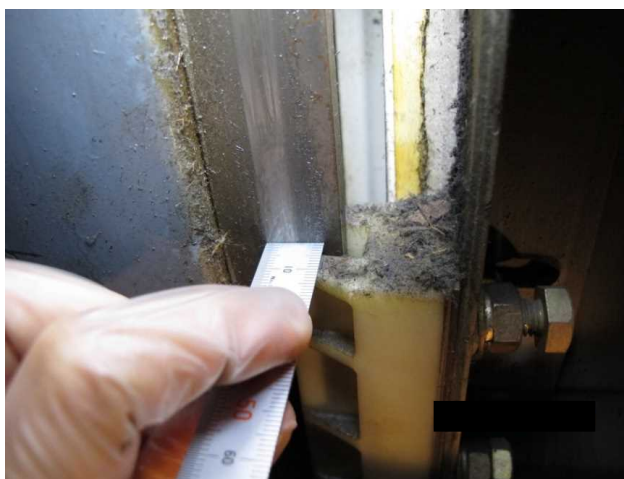
写真16. ドアガイドシュー隙間計測の様子
