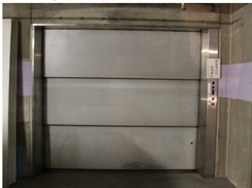
写真1. 乗場の戸（地下1階乗場側より撮影）
