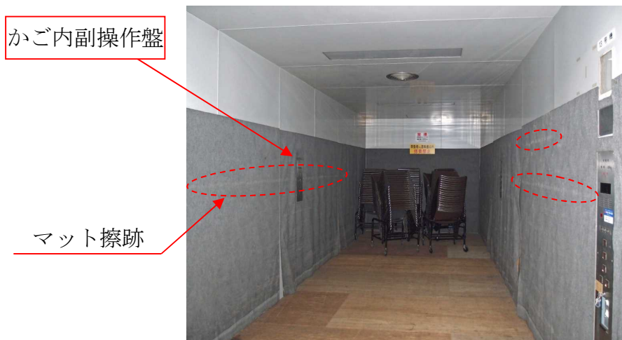
写真9. 事故当時の積載状況
