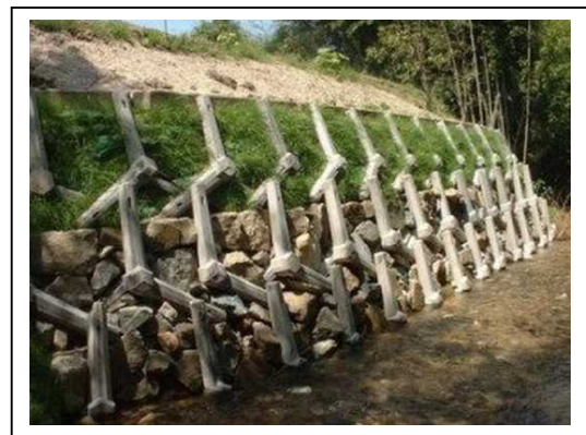
写真一 3 河川護岸適用
