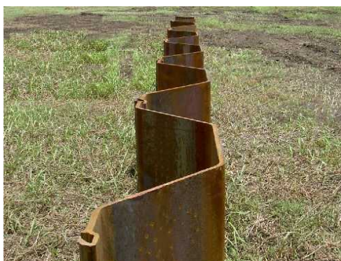
写真一 打設状況
