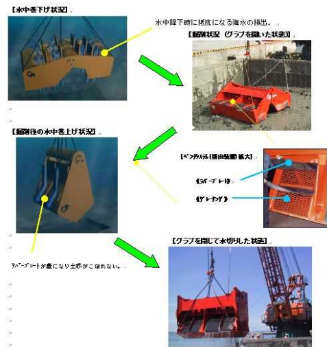
写真二 END グラブ施工状況
