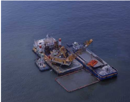
写真一 浚渫施工状況
