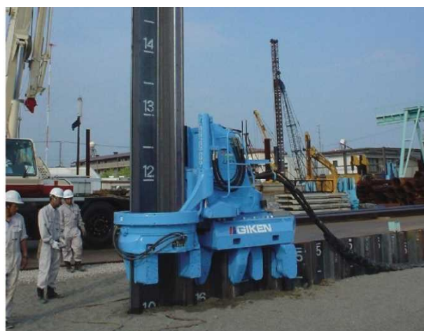
写真三 圧入施工
