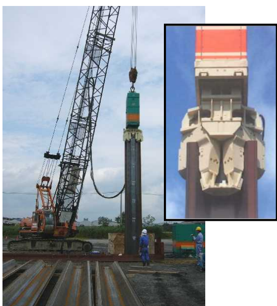
写真二 バイブロハンマ施工
