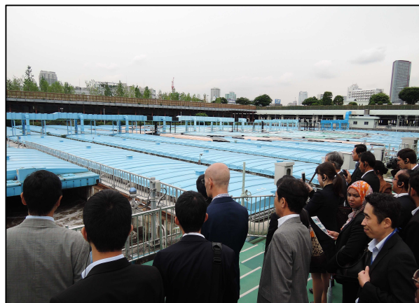
芝浦水再生センター（反応槽）
