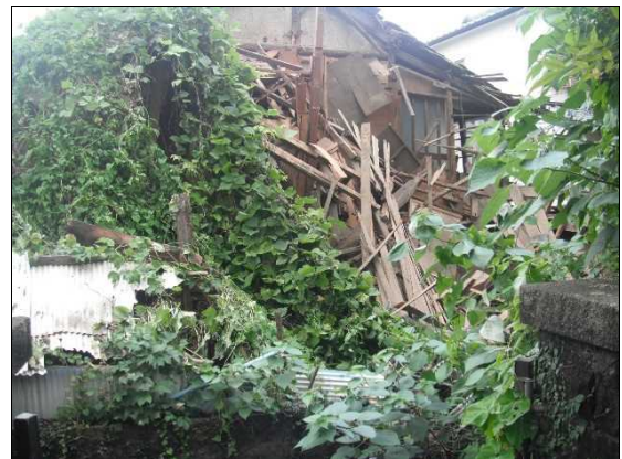
図表 除却前の空き家と除却後の空間活用
