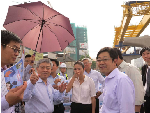
ホーチミン市都市鉄道1号線工事現場の視察
