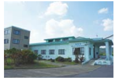
ICT プラザかさり
