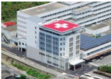
大島病院地域救命救急センター
