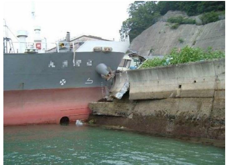
船舶が海岸保全施設を破壊した事例
