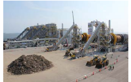
災害廃棄物中間処理施設(焼却施設)
