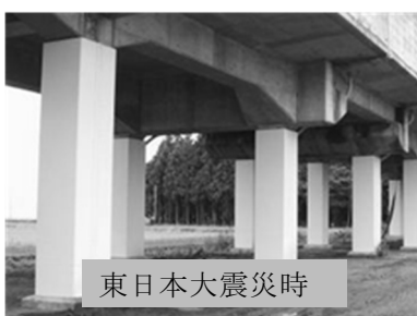
【高架橋の補強】
