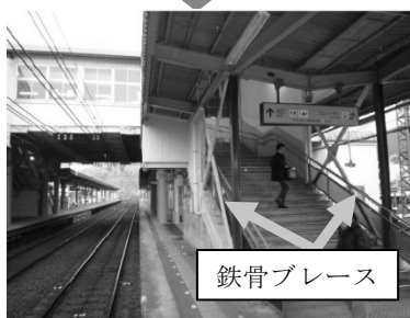
【橋上駅の補強】
