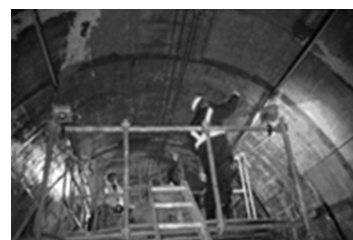
繊維シート貼付
