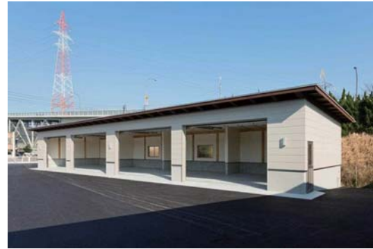
神戸税関境支署(車庫棟)
