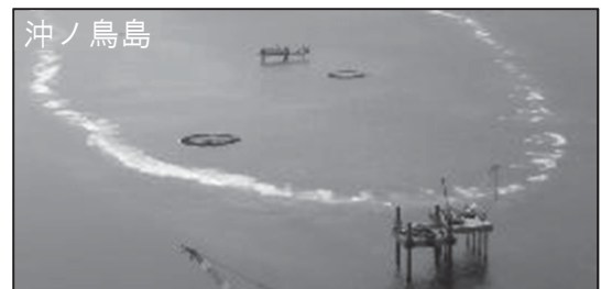
特定離島港湾施設の整備状況
