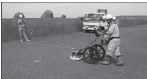
長寿命化計画策定に必要な空洞化調査の事例
