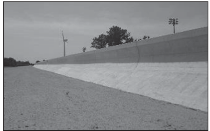
堤防嵩上げ状況：津松阪港海岸
