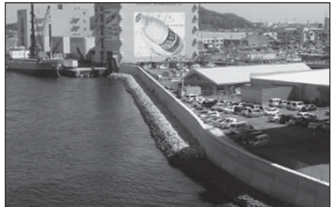
堤防嵩上げ状況：撫養港海岸
