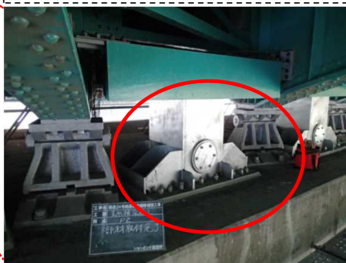
支承補強構造(橋軸直角方向)
