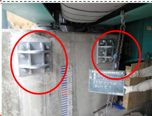
落橋防止装置(橋軸方向)
