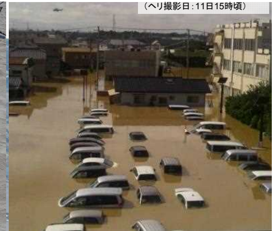
常総市役所から駐車場を撮影(撮影日:9/11) 周辺は浸水し、防災拠点の市役所も孤立化。
