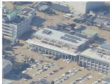
常総市役所の浸水の状況
